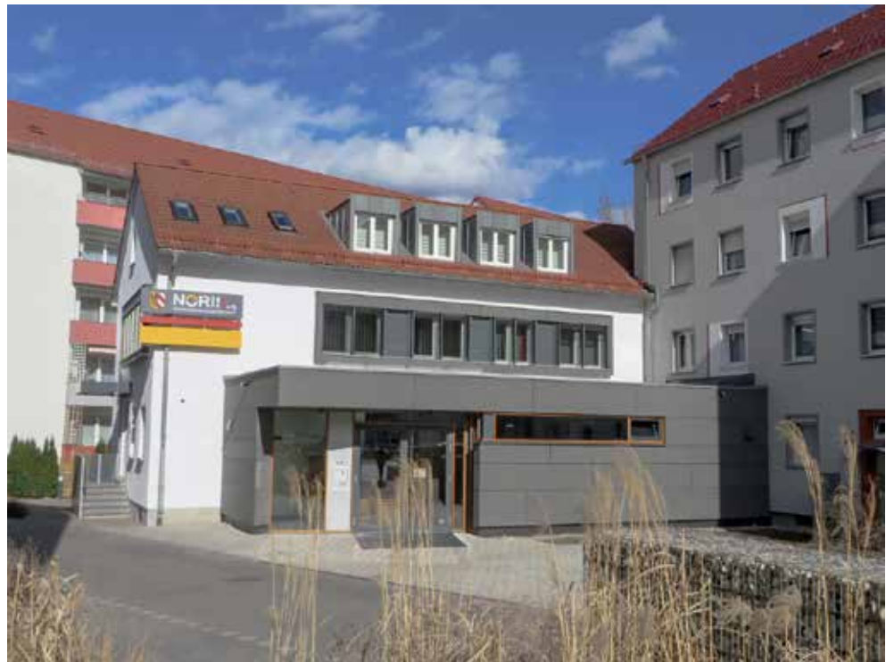
(Anbau Verwaltungsgebäude Herbartstraße 30)
