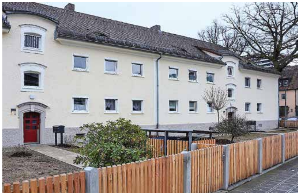
(Modernisierung mit Überarbeitung Außenanlagen Weddigenstraße 9-17)
