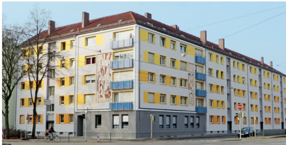
(Modernisierung Harsdörffer Straße)
