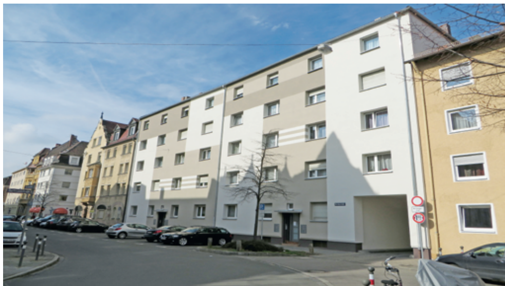
(Modernisierung Kirchenstraße 29-31, Frontansicht)
