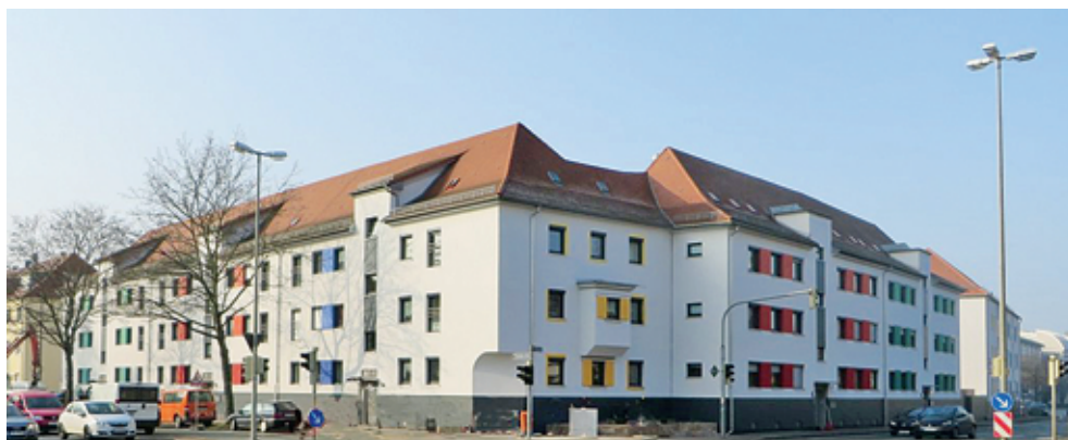
(Energetische Modernisierung „Maxfeld“)
