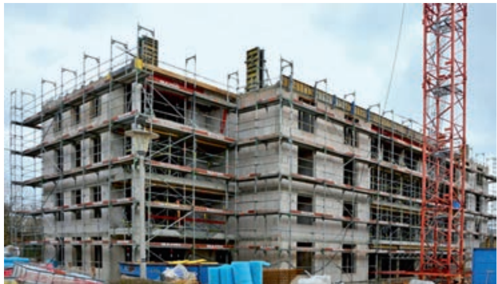
(Neubau Robert-Bosch-Straße 14 - 16, Zweibrückener Straße 12 - 12a, Rohbau)
