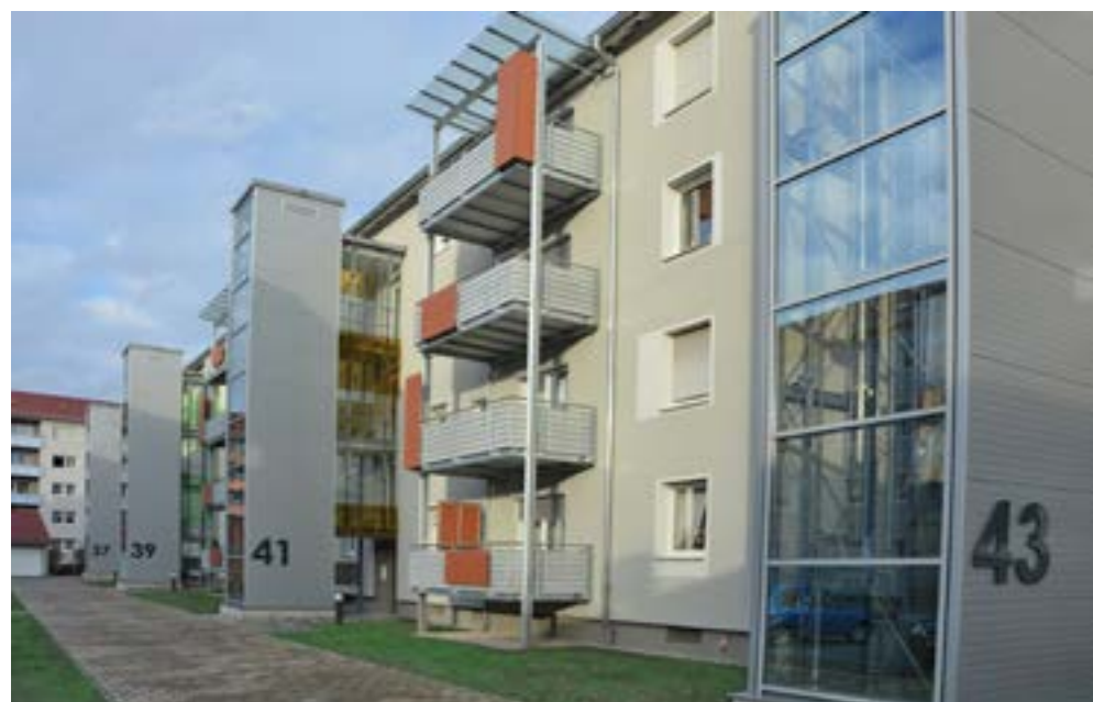
(Modernisierung Herbartstraße 37 - 43, Balkonanbauten)
