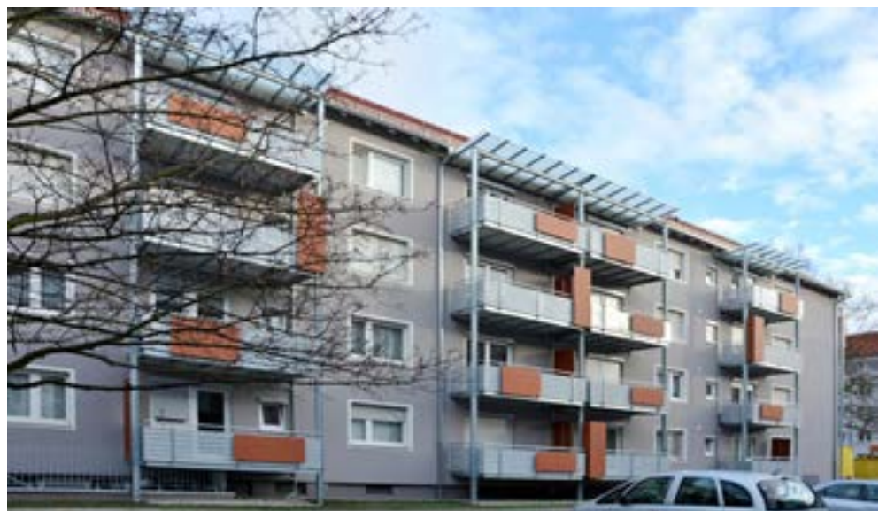
(Modernisierung Herbartstraße 45 - 47, Balkonanbauten)
