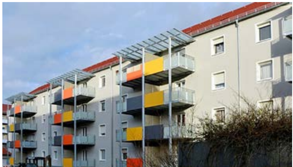
(Modernisierung Herbartstraße 31 - 35, Balkonbauten)
