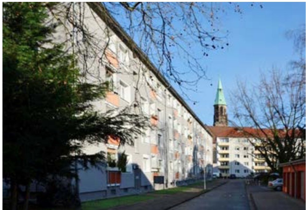
(Modernisierung Herbartstraße 45 - 51, Hauseingangsseite)
