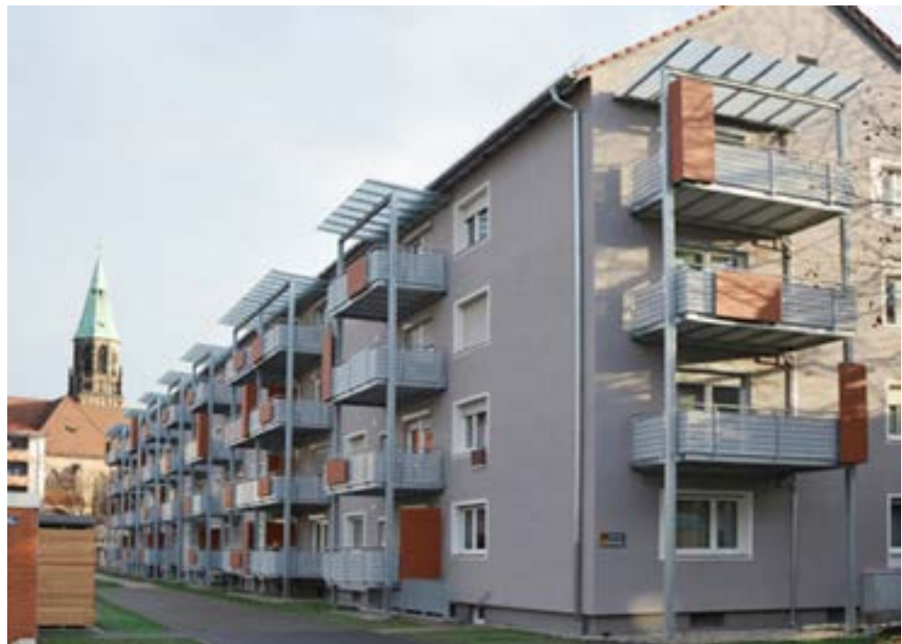
(Modernisierung Herbartstraße 45 - 51, Balkonbauten)
