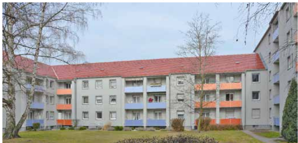
(Modernisierung Herbartstraße 16-28, Innenhof)
