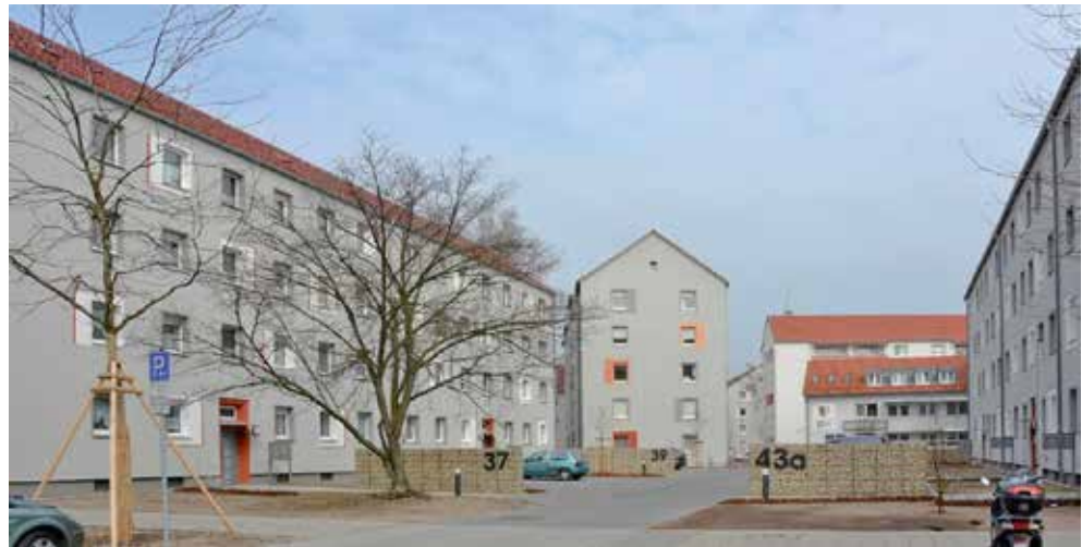
(Modernisierung mit Schaffung von Stellplätzen Wilhelm-Späth-Straße 37-43a)
