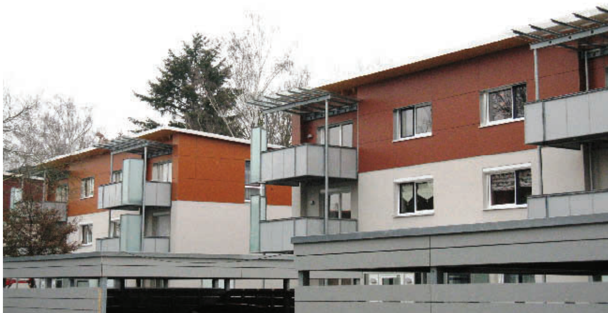
(Bauprogramm 2008 Semmelweißstr. 3, 5, 7, Modernisierung mit Aufstockung)
