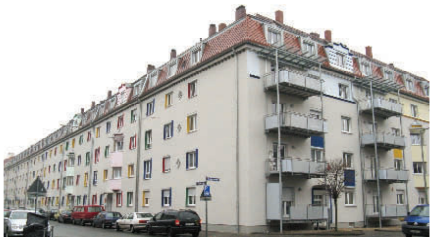
(Modernisierungsprogramm 2008, Peyerstr. 41-45, Pestalozzistr. 32-34)
