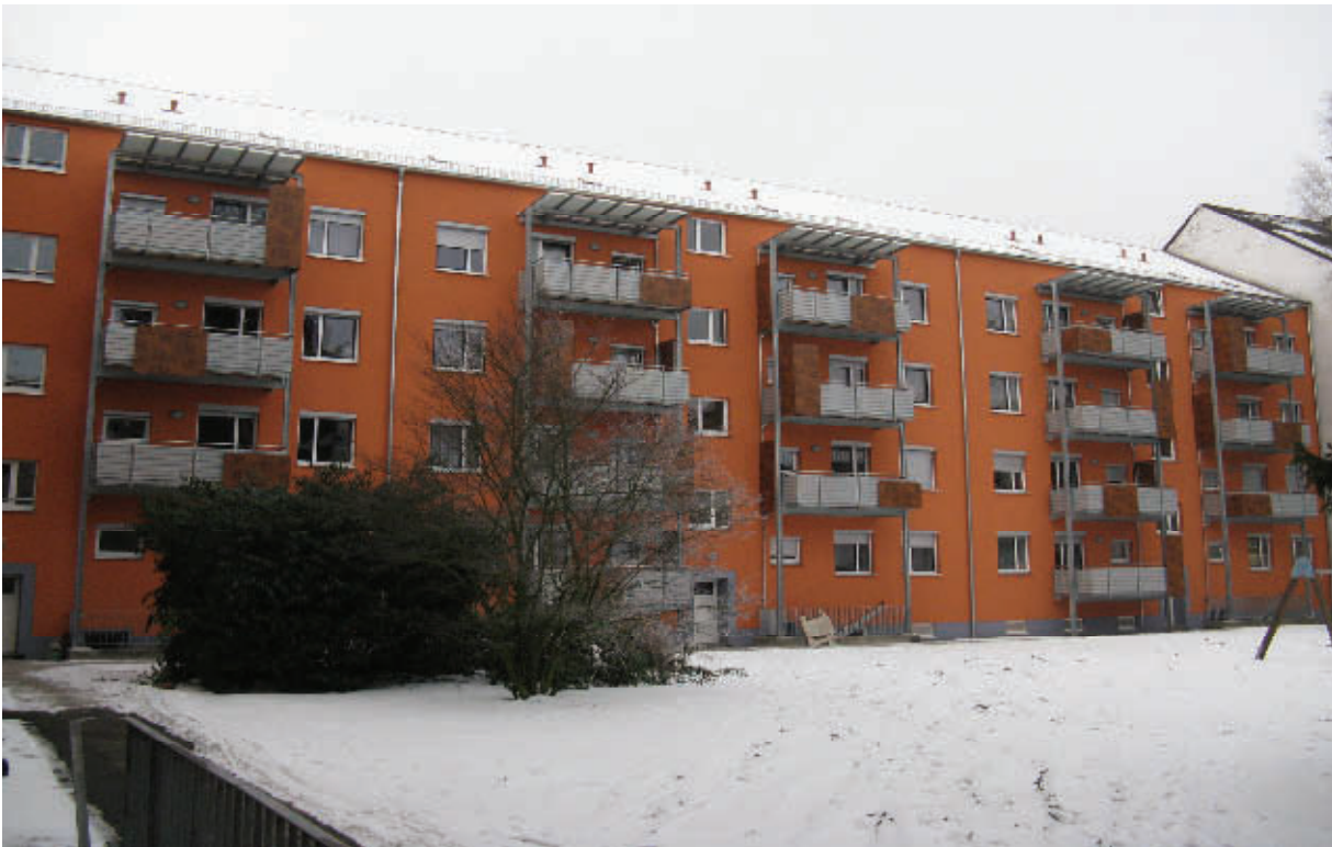
(Modernisierungsprogramm 2008, Schwanhardtstr. 39-43, Hofseite, Vollwärmeschutz mit Balkonanbau)
